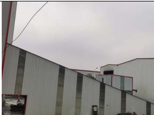
封闭输送廊道
