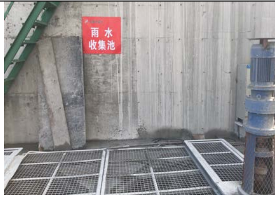
初期雨水收集池
