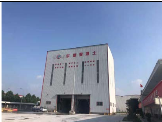
封闭式搅拌楼
